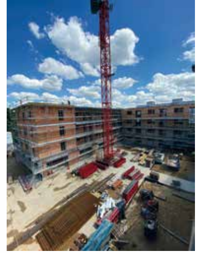
Baustellenansicht von oben
